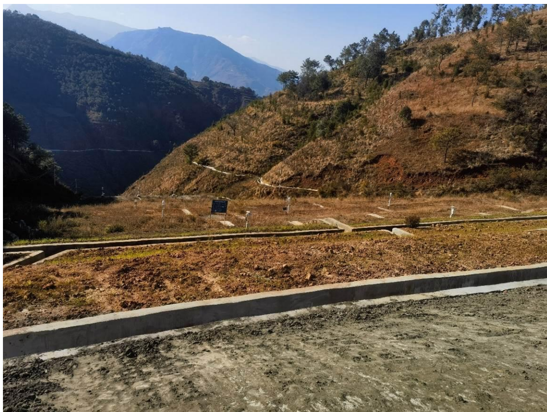
图 2-5 堆积坝及坝面排水沟
