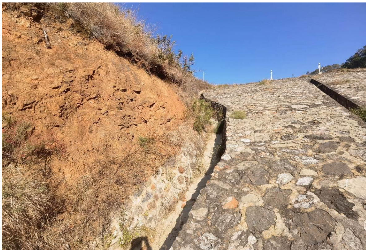
图 2-9 初期坝坝肩排水沟
