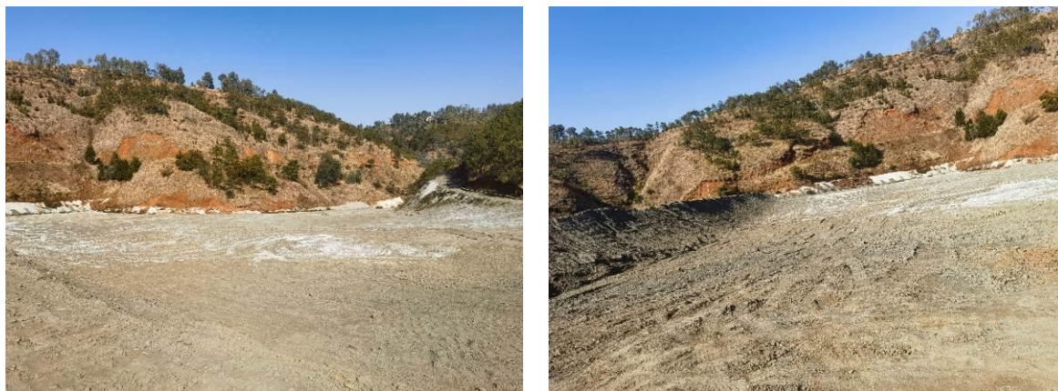
图 2-3 尾矿库库区滩面
