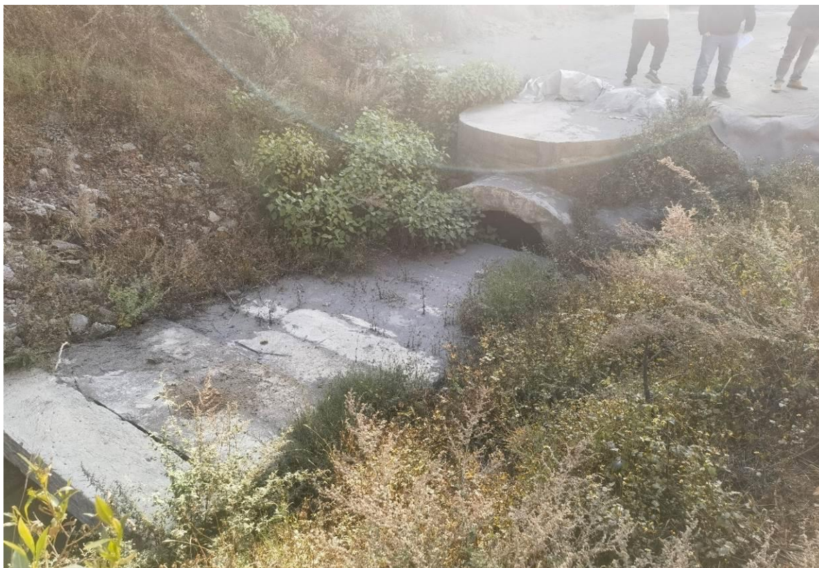
图 2-18 排水斜槽与排水涵管对接处
