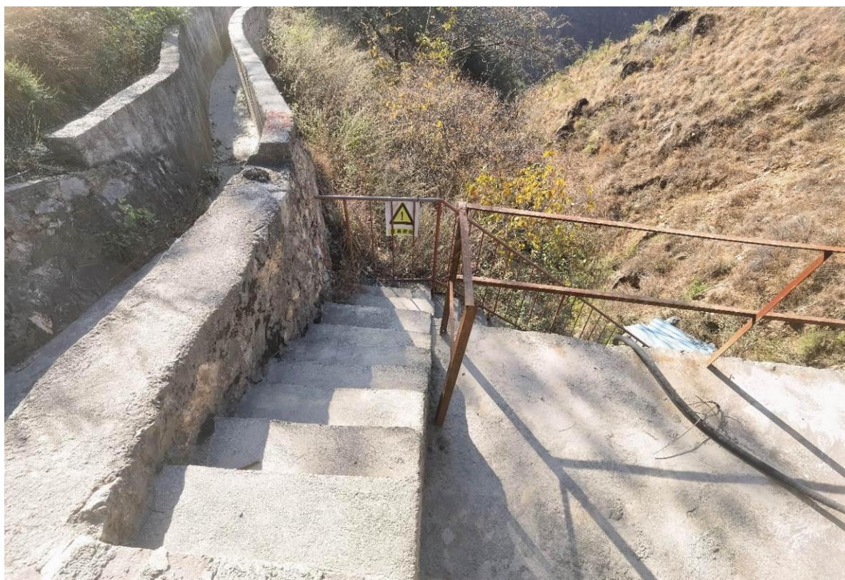
图 2-8 初期坝坝脚侧截洪沟
